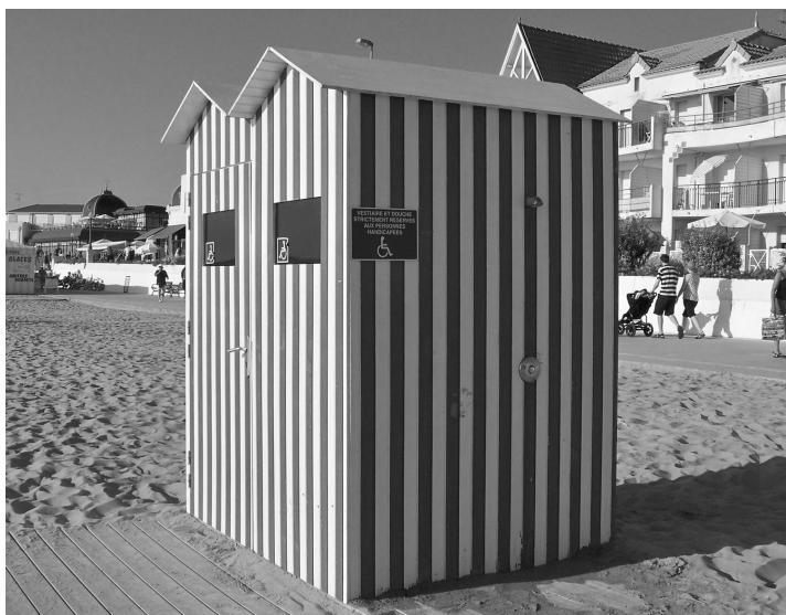
Fig.3 – Vestiaire et douche adaptés à Châtelailon-Plage
