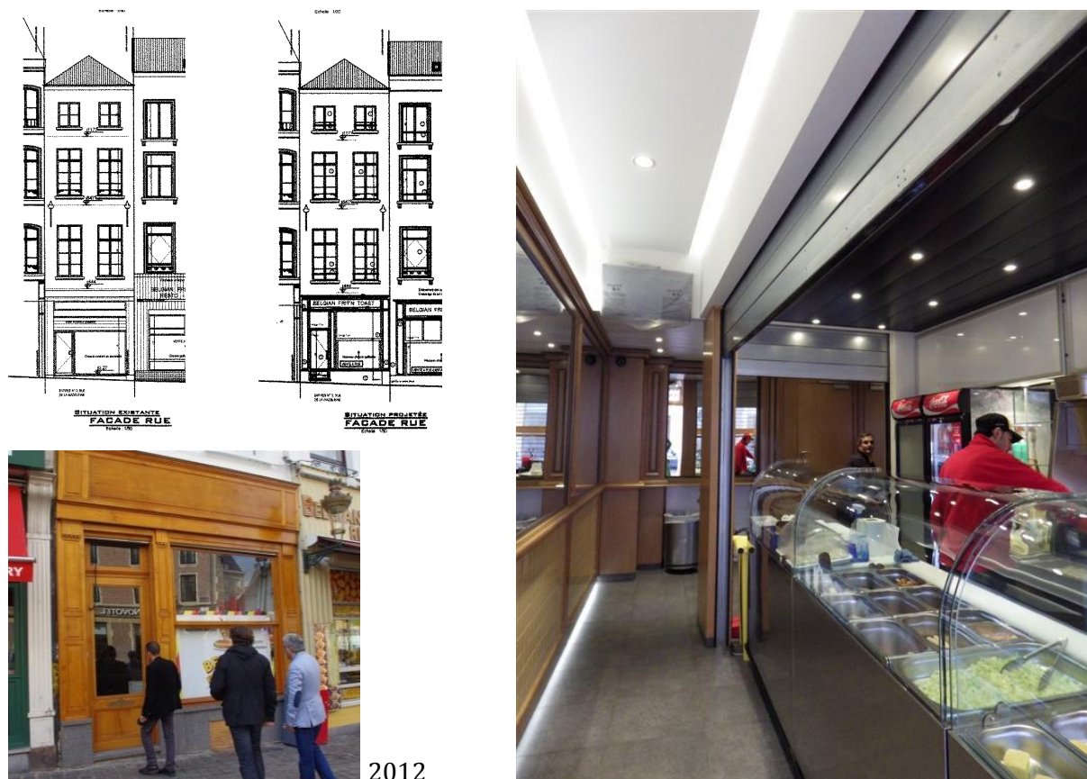
Figure 17 : Création d'un nouvel accès aux étages, immeuble rue de la Madeleine 3.
