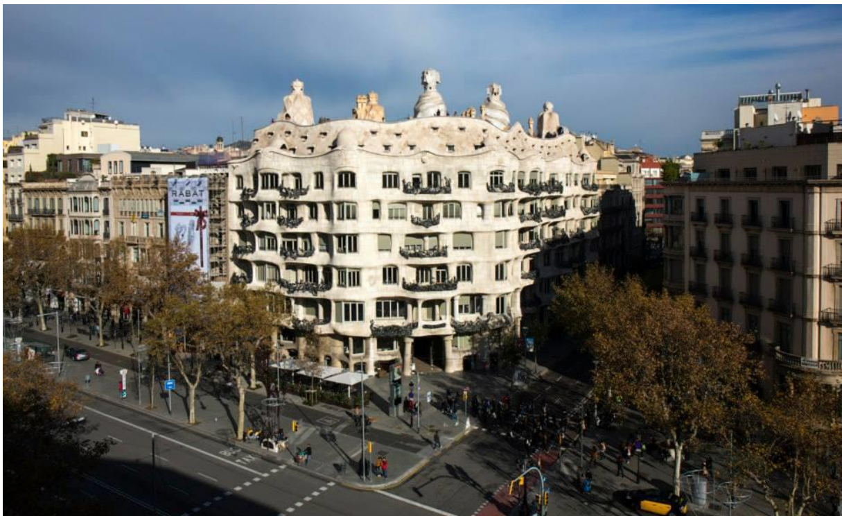
Figure 25: Casa Milà, Barcelona (Source : Jordi Tresseras)
